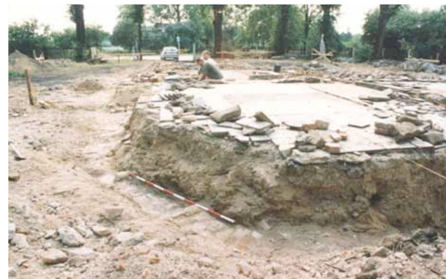
Obr. 5 – Ostrava-Hrabová, kostel sv. Kateřiny, archeologický výzkum 2003. Základové zdivo jižní zdi presbytáře kostela v průběhu archeologické dokumentace, pohled od západu. Foto: Michal Zezula, 2003.
