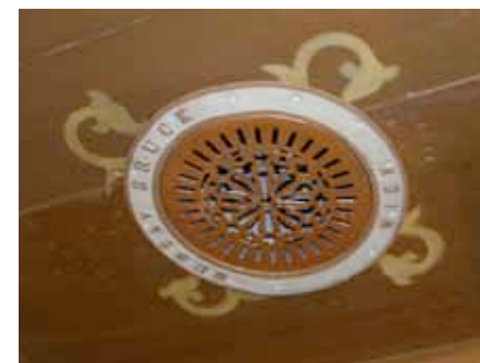
Krnov, synagoga, detail odsávací ventilační mřížky v kazetovém stropě (foto Hana Pavelková, 2013).
