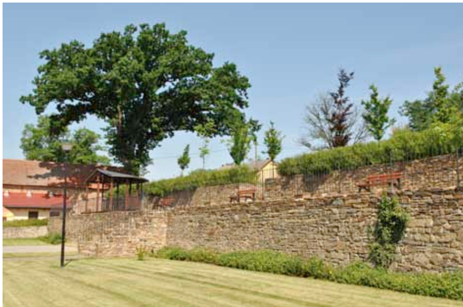
Jezdkovice – zídky a terasy po rekonstrukci (foto Alena Halamíčková, 2014).
