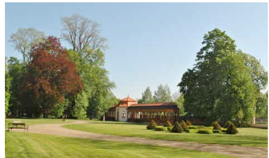
Kunín – parter s obnovenou kuželnou (foto Alena Halamičková, 2014).
