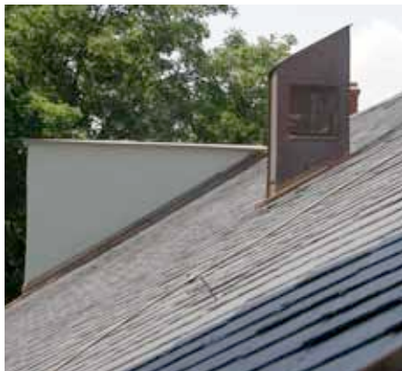
Krnov, synagoga, detail obnoveného větracího komínku na nově opravené střeše (foto Hana Pavelková, 2013)
