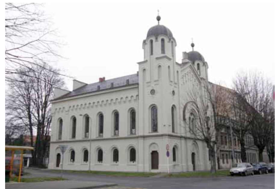
Krnov, synagoga po obnově vnějšího pláště v roce 2013 (foto Hana Pavelková, 2014).
