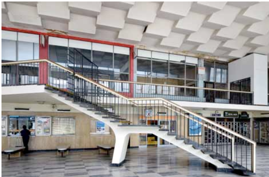
Schodiště v odbavovací hale na galerii v patře (foto Roman Polášek, 2014).
