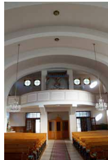
Kostel sv. Viléma Aquilánského ve Vřesině, pohled na kruchtu a hlavní vstupy (foto Adam Hubáček, 2014).
