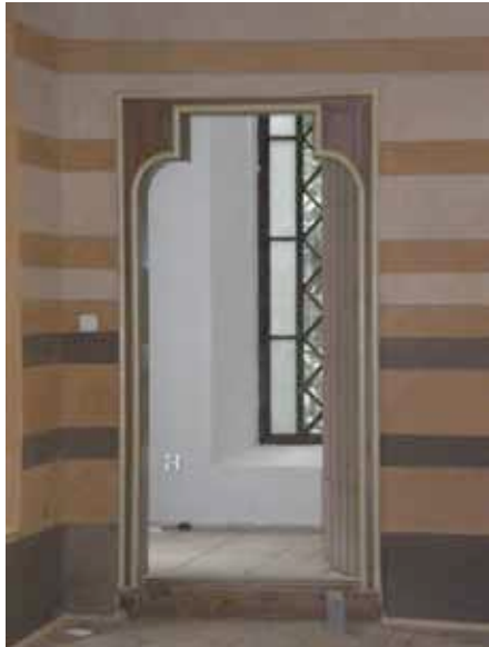
Krnov, synagoga, repasované původní rámy a obložky, dveře v severní věži při výstupu na ženskou galerii (foto Hana Pavelková, 2013).
