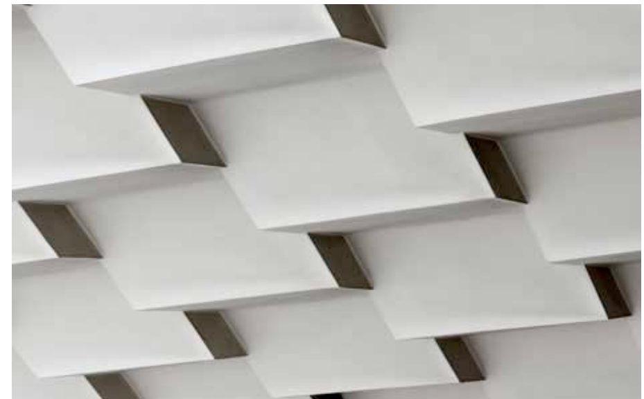
Strukturovaný prolamovaný stropní podhled odbavovací haly (foto Roman Polášek, 2014).
