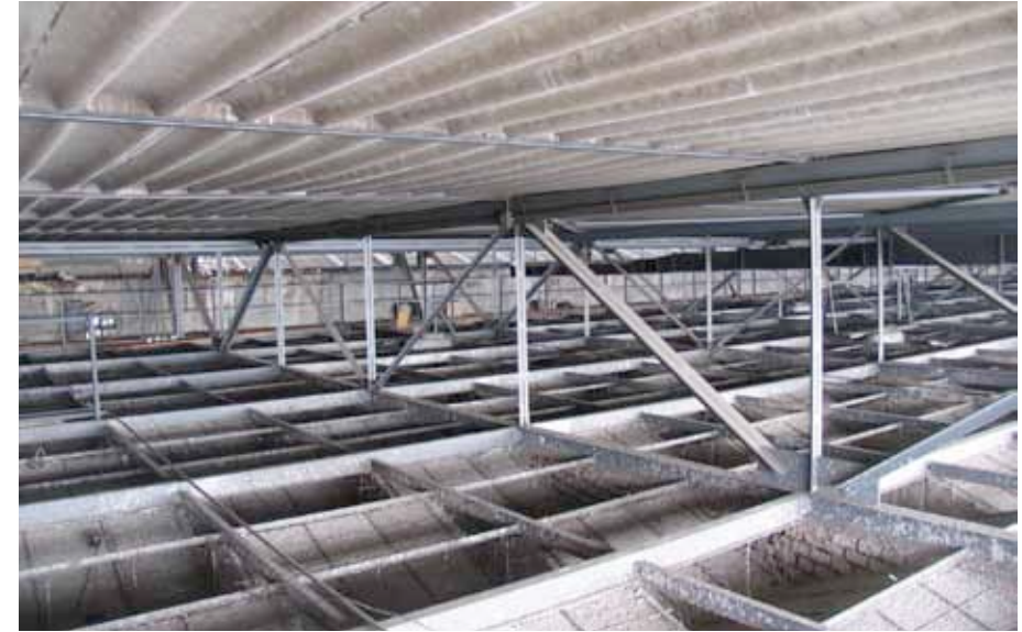
Prostor podstřeší nad stropním podhledem odbavovací haly (foto Martin Strakoš, 2011).
